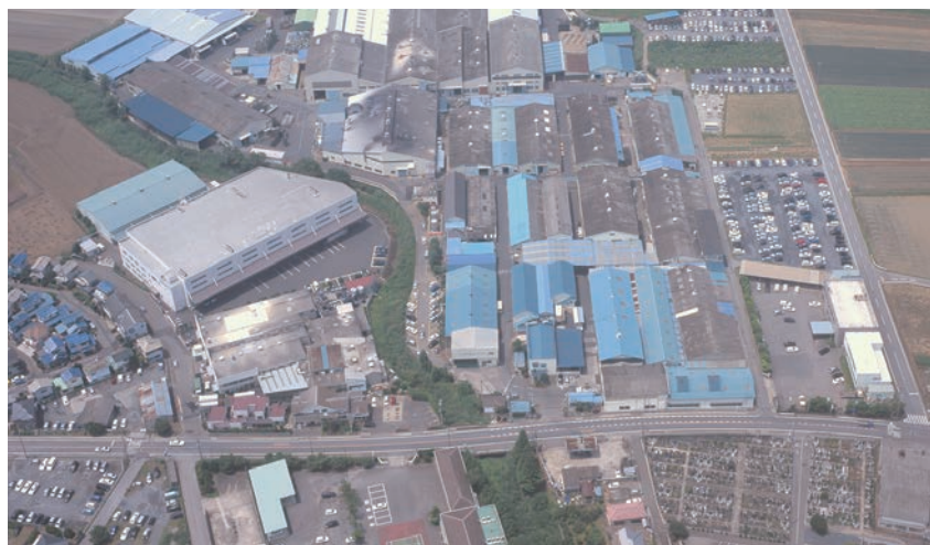
埼玉県熊谷市のリード本社/本社工場。広大な敷地で自動車メーカーのサプライヤーとして樹脂成形・塗装技術を用いたバンパーやドアなどの設計・製造等を行っている。
