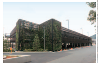
広島県福山市の県営鍛冶駐車場。海に面した場所で壁面緑化を行い、景観に融合している。2017年1月竣工
