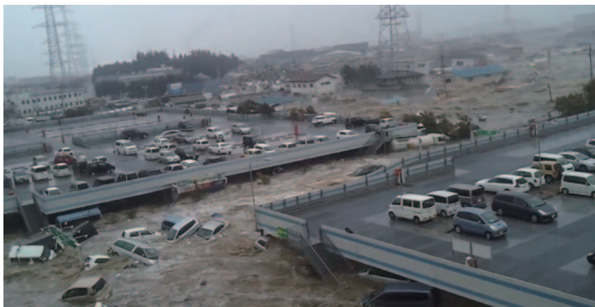
2011年3月の東日本大震災では、津波被害に遭った地域で大臣認定自走式駐車場が津波の圧力に耐え、住民の避難場所として機能した(本田 豊氏撮影)。
