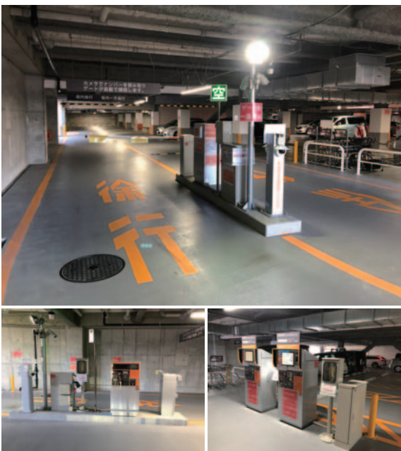
車両認証&チケットレス+ゲートレス「アイスルー」の導入事例。フレスポひばりが丘は、2019年10月、大和リース株式会社が東京都西東京市にグランドオープンした複合商業施設。精算機3台(事前機2、出口精算1、遮断機1 /カメラ3台)
