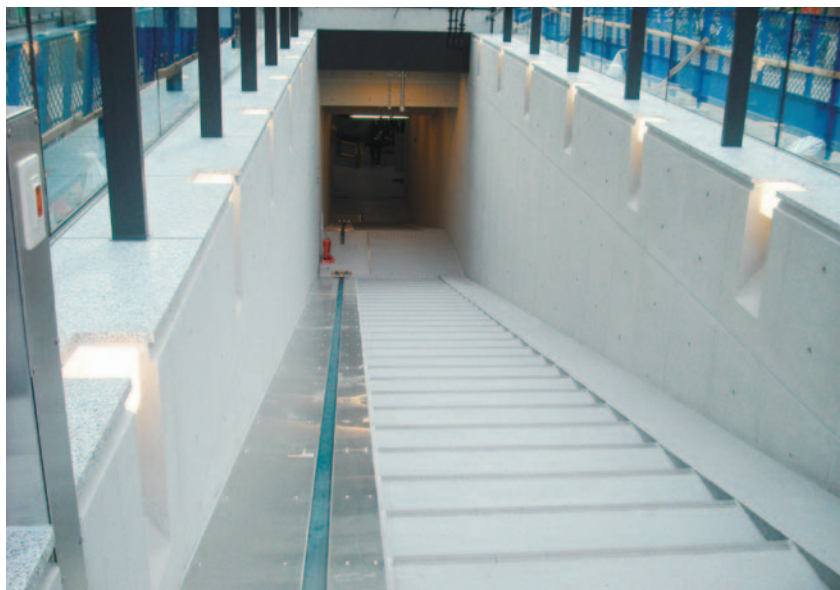
特に都市部の大規模な自転車駐車場において、精算機や駐輪ラック、そしてオートスロープは欠かせない製品になっている。左端が協栄システムの協栄オートスロープ
