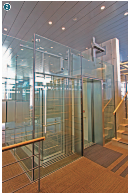
①昇降旋回型自動車用エレベーター(ターンカーリフト)。目的階まで旋回しながら昇降し、目的階に到着したときは入出庫しやすい前面の向きになっているため、入出庫の時間を大幅に短縮できる ②東京理科大学に納入したエレベーター。かこの真下に油圧シリンダーを配置し、シリンダー上下の動きのみで直接かごを昇降させるため、すっきりとした見栄えのガラス仕上げにした
