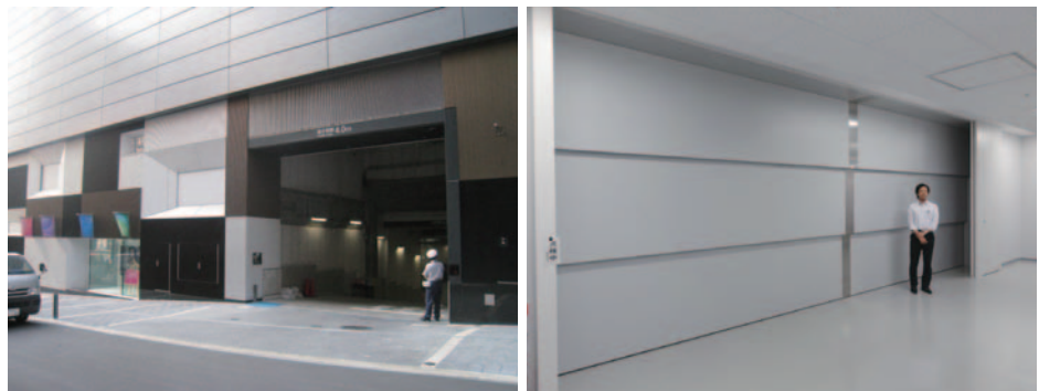
渋谷ヒカリエに積載荷重10t、行程60mという超大型エレベーターを納入 荷物搬入路の間口は実に8mという広さ（右写真）
