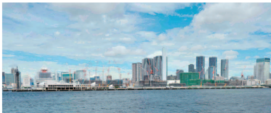
東京2020大会の選手村建設が進む晴海。大会閉幕後は再開発され、分譲賃貸合わせて5,600戸超の住宅がつくられる計画だ。公共交通機関の整備も大きな課題に
