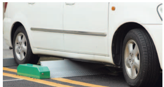
ロックレス駐車場のモデル。ネットワーク対応精算機、場内モニターカメラのほか、各車室にナンバー認識カメラ、埋設された車両センサーがある
