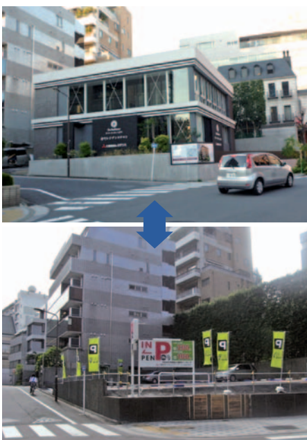
転用が容易なため、3年間でマンションのモデルルーム⇄駐車場の転用を繰り返し、最大限の収益創出に成功した現場
