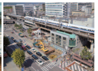
京都駅八条口 西・東自転車駐車場としてエコサイクル3基が導入された。2015年1月完成。新幹線軌道に近く、交通量の多い道路下という制約条件の多い案件だったが、周囲への影響を最小限に抑えて施工。現在、京都市庁舎前にも、2基を整備中
