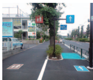
広い歩道を利用した自転車走行空間 (東八道路：構造的分離)
