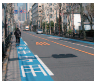
車道を活用した自転車レーン (旧玉川水道道路)
