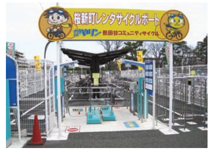
東急田園都市線桜新町駅そばにあるコミュニティサイクルのポート。ゲート奥は太陽光発電パネルと電動アシスト自転車スペース
