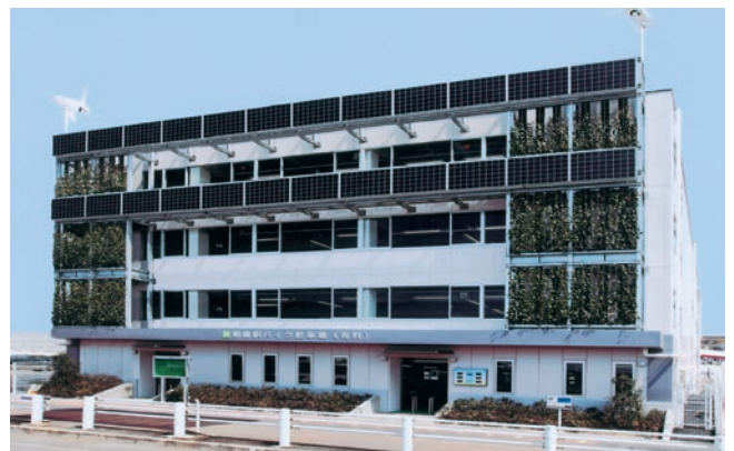
朝霧駅バイク駐車場(兵庫県・明石市)。風力発電、太陽光発電並びに壁面緑化も行う環境に配慮した設計。ミニバイク(第1種原動機付自転車)専用で計760台収容
