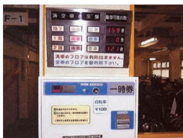
管理業務の合理化と利用者の利便性向上を両立させるため、一時利用の空状況を自動管理するシステム（写真左。吉祥寺大通り東自転車駐車場。東京都・武蔵野市）や、自動ゲートを導入（写真右。八王子駅北口地下自転車駐車場。東京都・八王子市）
