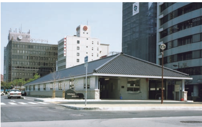
阪神尼崎駅南自転車駐車場(兵庫県・尼崎市)。市内寺町の寺院と尼崎城をイメージした和風建築。屋根を寄棟造りの瓦葺き、外壁腰壁に石垣を採用している
