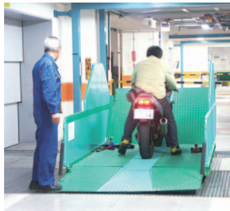
昨年11月に神奈川県横浜市で行われた立体機械式駐車用のオートバイ専用駐車設備のモニター体験会 (財団法人 駐車場整備推進機構提供)
