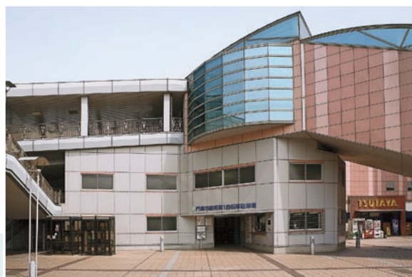
門真市駅南第1自転車駐車場。橋上駅化工事および同駅連絡道路橋工事に合わせ、その高架下を活用して建設(立体自走式)
